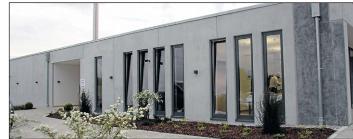
Auch die Außenanlagen wurden in der vergangenen Woche fertiggestellt und bepflanzt. Direkt vor dem Crema befinden sich ausreichend Parkplätze.
